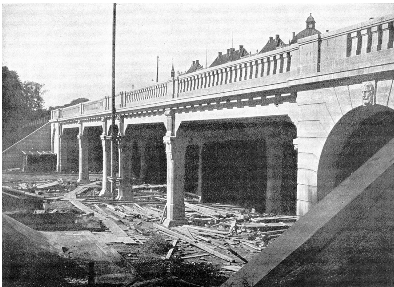
Fig. 72. Viadukten for Østerbrogade.
