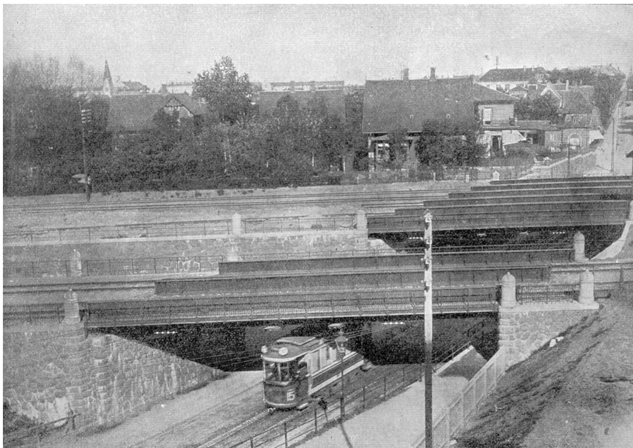
Fig. 82. Viadukten over Hellerupvej.
