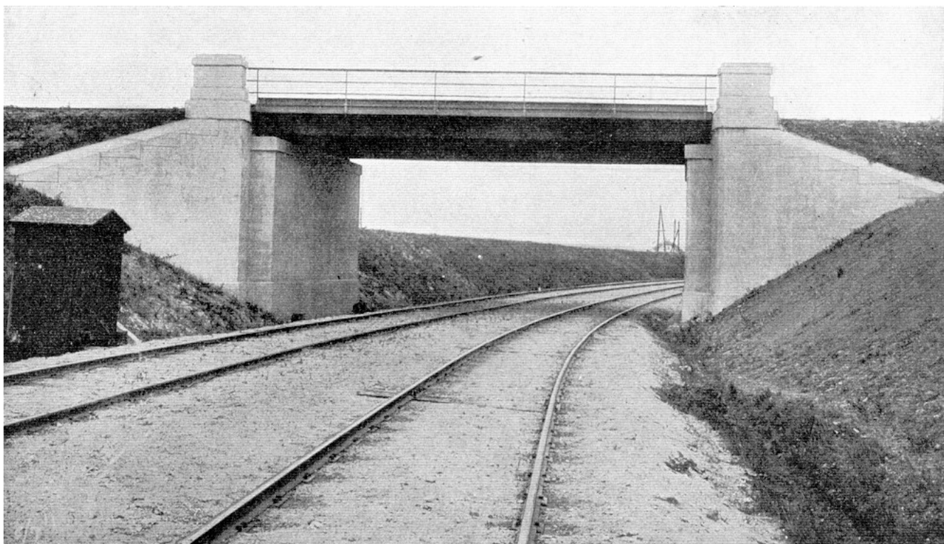
Fig. 96. Den nye Vestbanes Viadukt over Godsbanen.
